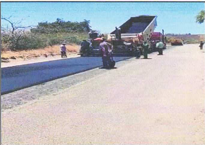
TENDIDO Y COMPACTACIÓN DE CARPETA ASFALTICA.
