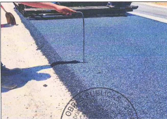
TENDIDO Y COMPACTACIÓN DE CARPETA ASFALTICA.
