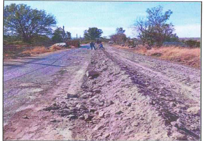
COMPACTACIÓN DE MATERIAL DE BANCO.
