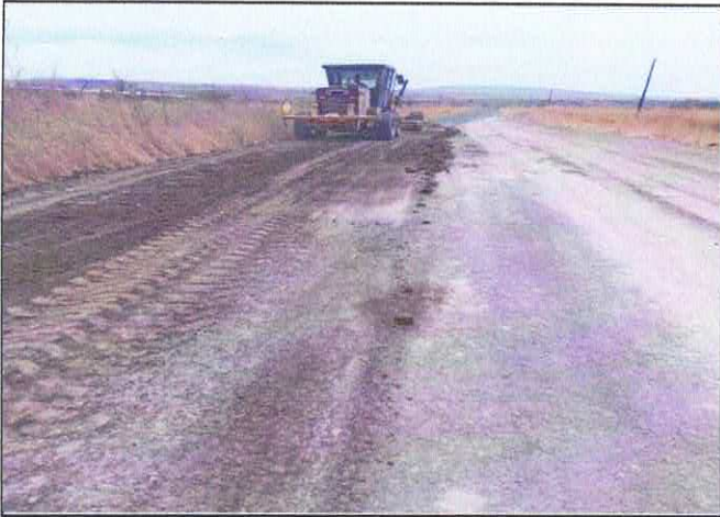
COMPACTACIÓN DE MATERIAL DE BANCO.
