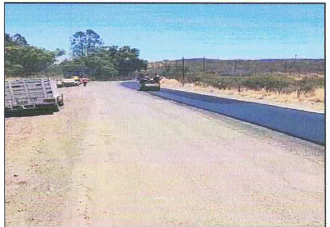
TENDIDO Y COMPACTACIÓN DE CARPETA ASFALTICA.
